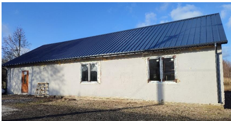
Wymiana pokrycia dachowego na świetlicy wiejskiej w m. Niechodzin
