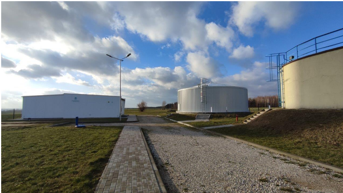
Stacja uzdatniania wody w m. Gumowo
