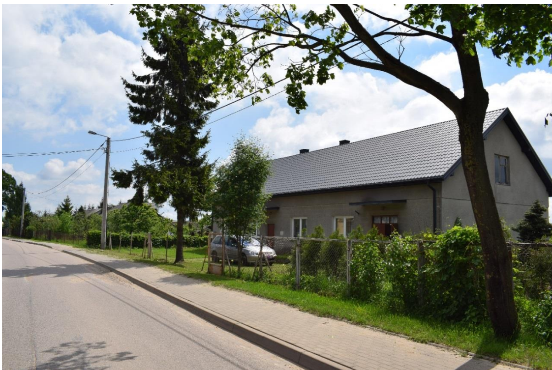
Świetlica wiejska w Woli Pawłowskiej – łączny koszt inwestycji 36.627,34 zł (wymiana pokrycia dachowego)
