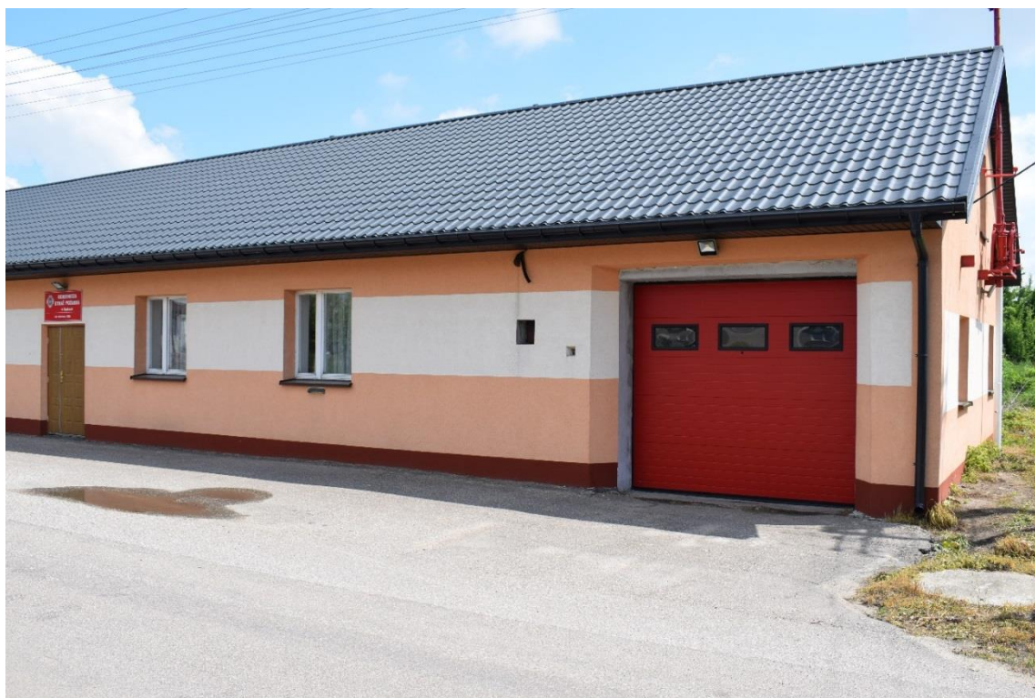
Remiza OSP w Gąskach – łączny koszt inwestycji – 43.231,79 zł (wymiana pokrycia dachowego i drzwi garażowych)
