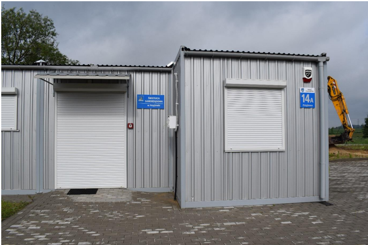
Świetlica wiejska w Prążewie – łączny koszt inwestycji 298.318,16 zł
