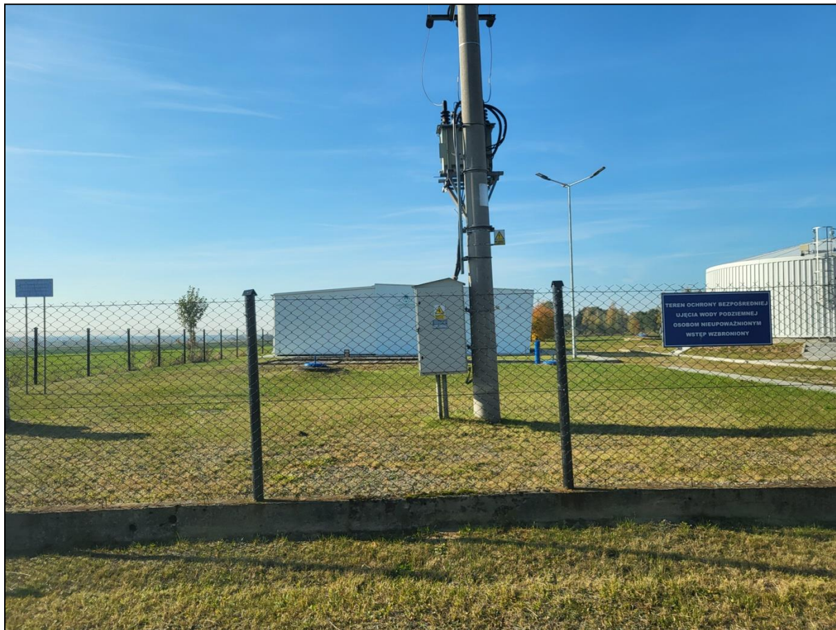
Ryc. 25. Ujęcie wody ze strefą ochronną na terenie gminy Ciechanów
